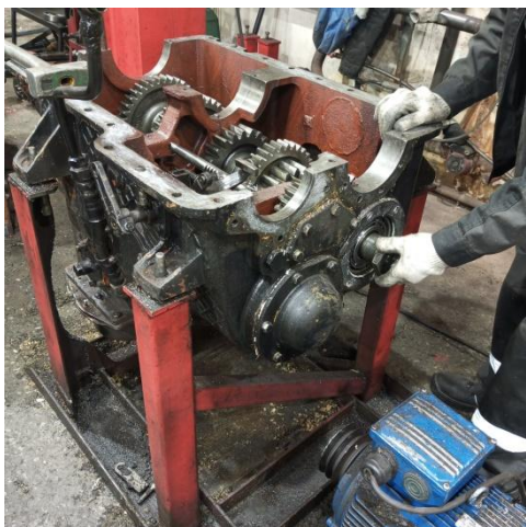
Рис. 1 - Разборка КПП К-701
